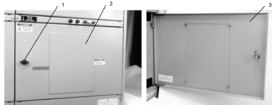
Fig. 3-17. Compartimiento para interruptor futuro
